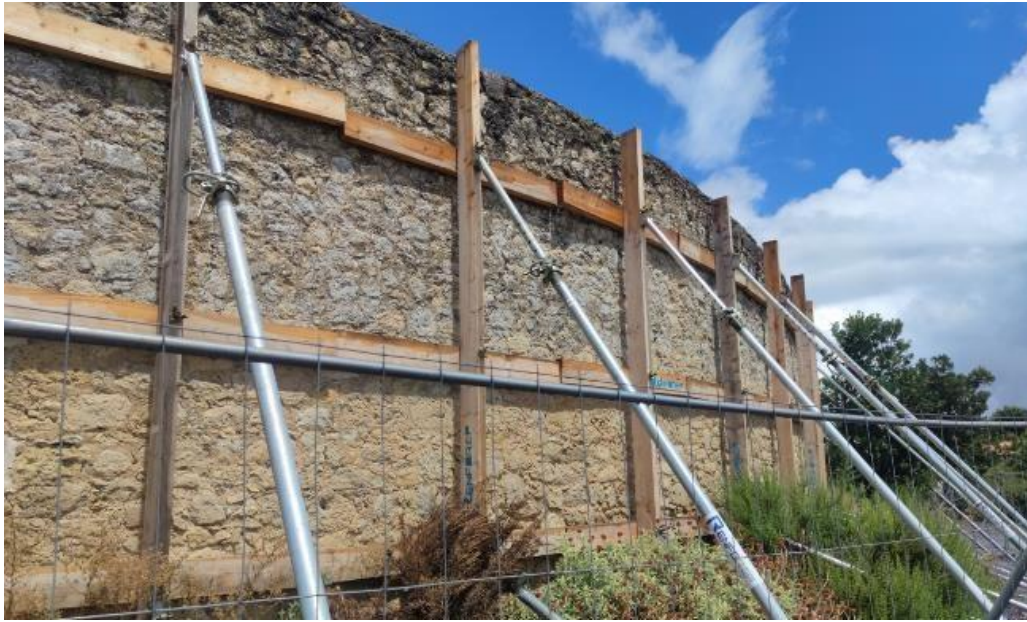
Figure 2 : Confortement à court terme du mur d'enceinte
