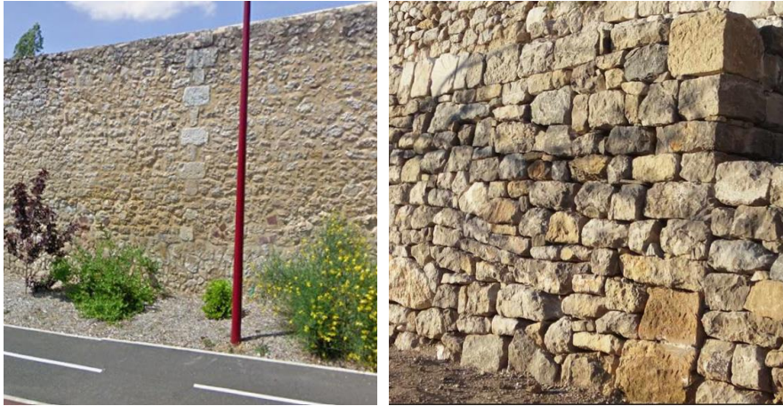
Figure 13 : Chaînage intermédiaire existant sur le mur (photo de droite) ; Exemple de chaînage d'angle (photo de gauche)
