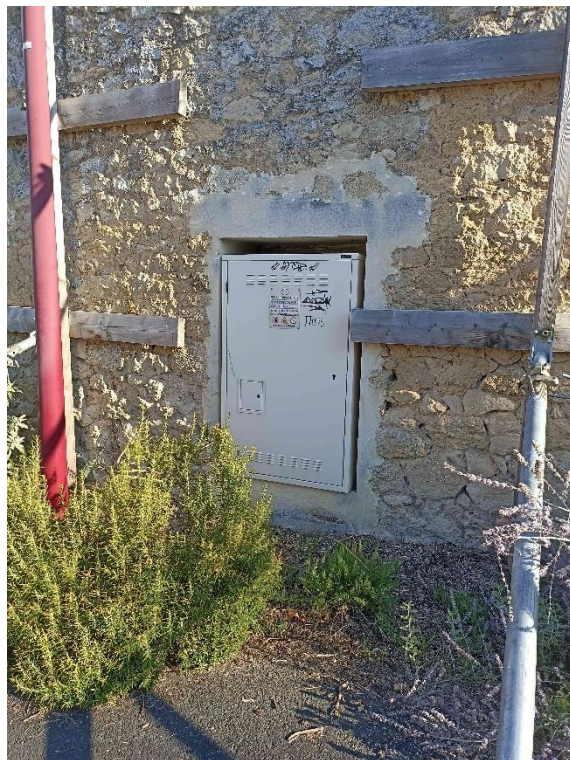
Figure 10 : Source Hôpital Cadillac – Mur section 2 Partie B – Présence branchement gaz à conserver
