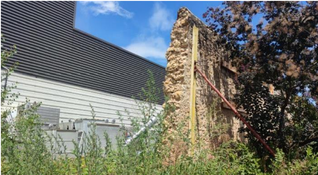
Figure 3 : Partie du mur effondré
