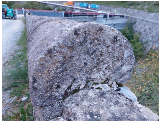
Figure 12 : Exemple de pierre de couronnement – chaperon de forme arrondie
